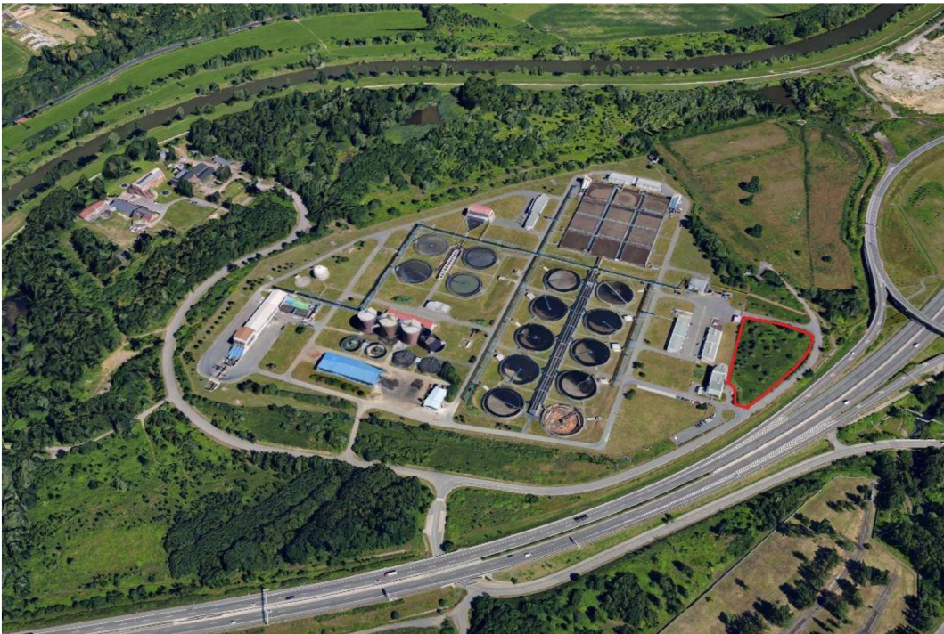
Obrázek 1 - Ústřední čistírna odpadních vod v Ostravě – Přívoze
