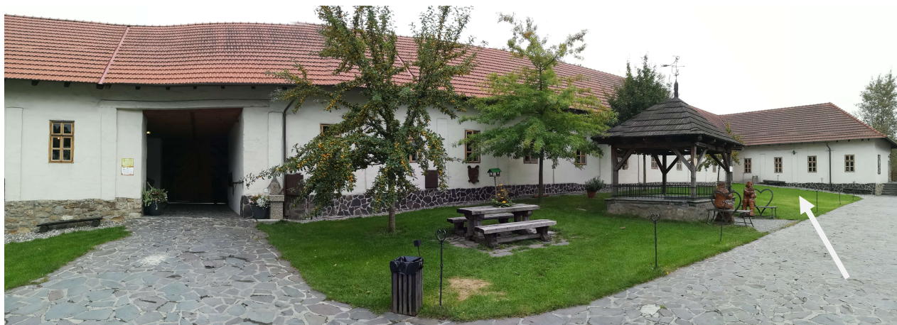
Pohled na část stavebního pozemku s kašnou, kde má být umístěn herní prvek
