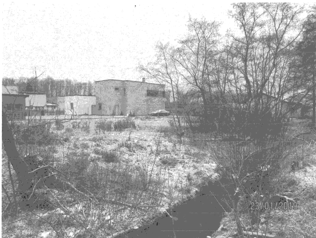
POHLED OD SEVEROVÝCHODU
