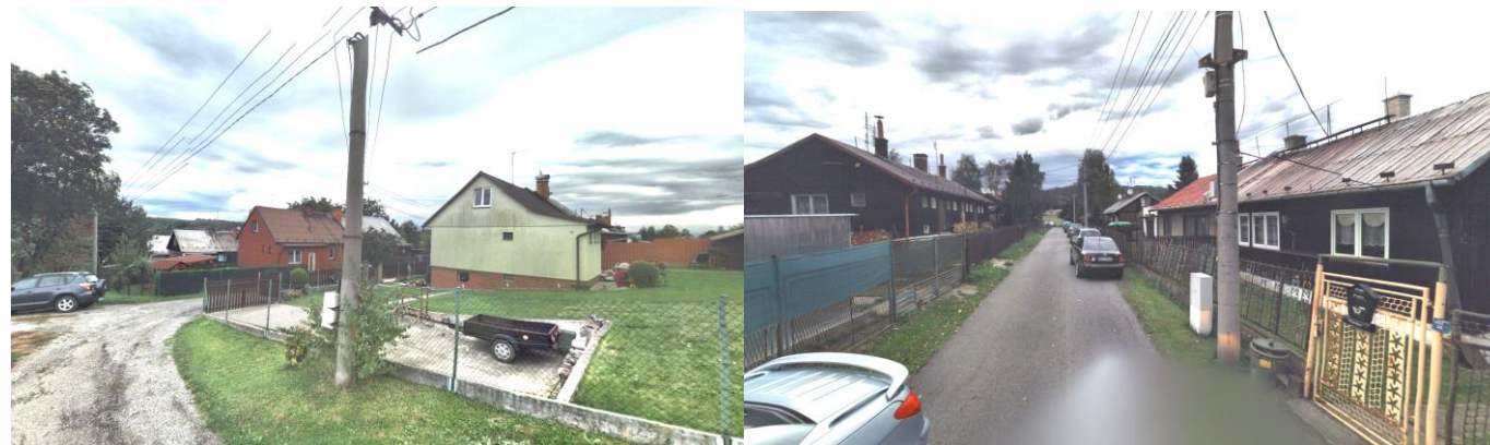
Charakter zástavby sousedních ploch (původně domky dělnické kolonie, dnes stavebně upravené)
