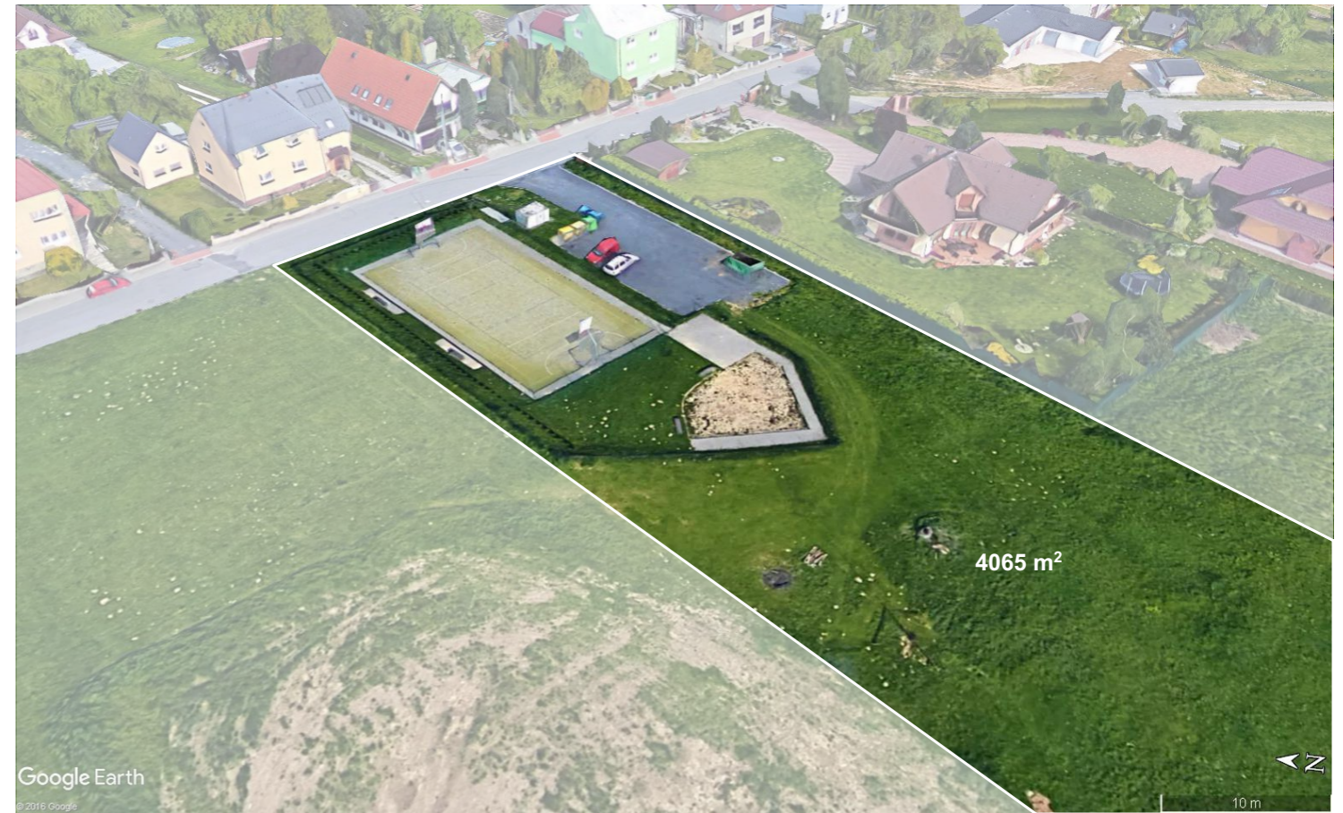
NADHLED ZÁPADNÍ - STÁVAJÍCÍ (ZDROJ: www.google.cz)
