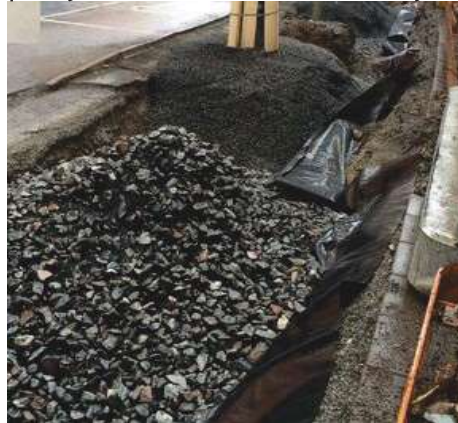
strukturní substrát pro výsadbu stromů a retenci vody
