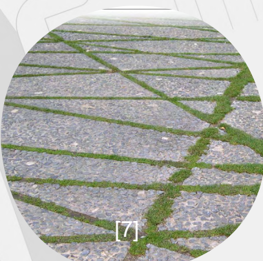
rozřezaný asfalt původních cest
