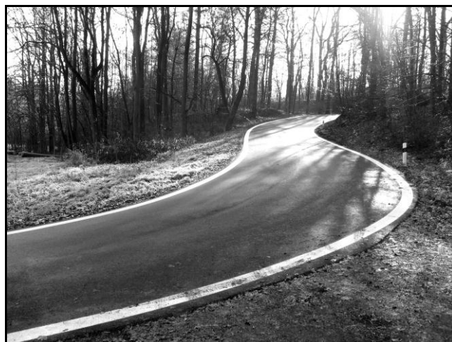
souvislá údržba ul. Vlnitá
