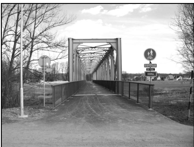
zrekonstruovaná lávka přes Odru odb. Ryšových
