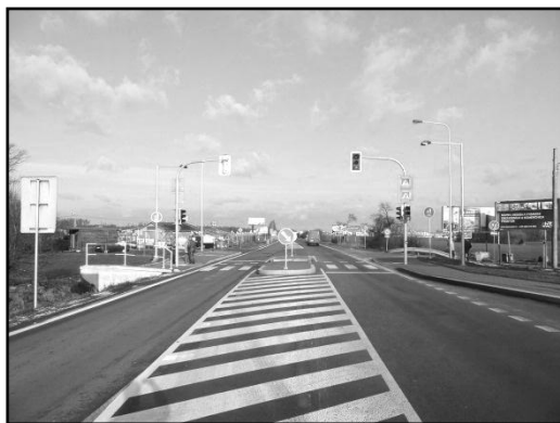
ul. Plzeňská (foto Ing. Martin Krejčí)
