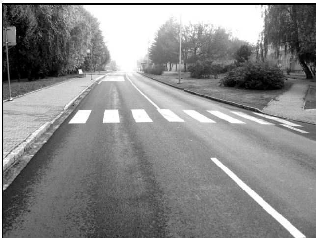
souvislá údržba ul. Průběžná
