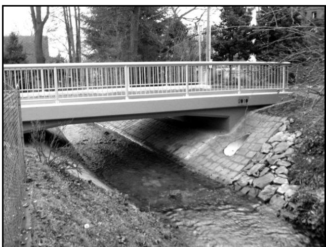
zrekonstruovaný most ul. Jezerní, potok Ščučí
