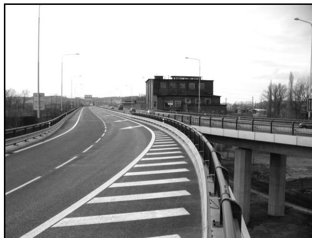
Ul. Místecká, I. stavba
