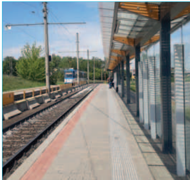
Terminál Dubina (nové zastřešení)
