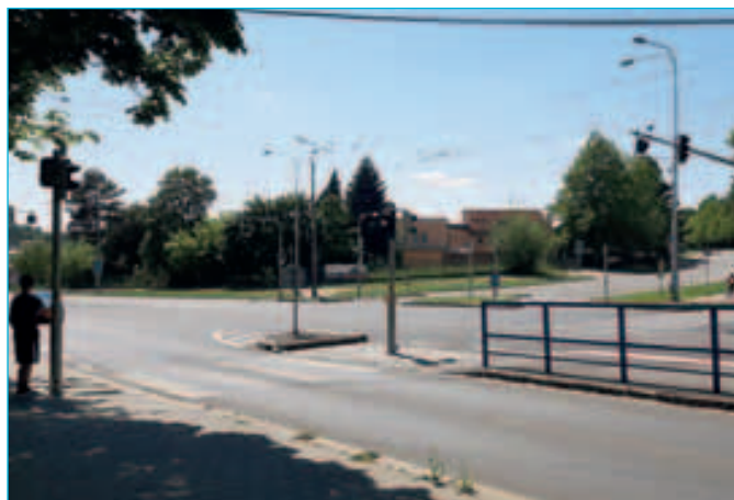
Opravené SSZ kř. 17. listopadu x Nábřeží SPB x K Myslivně
