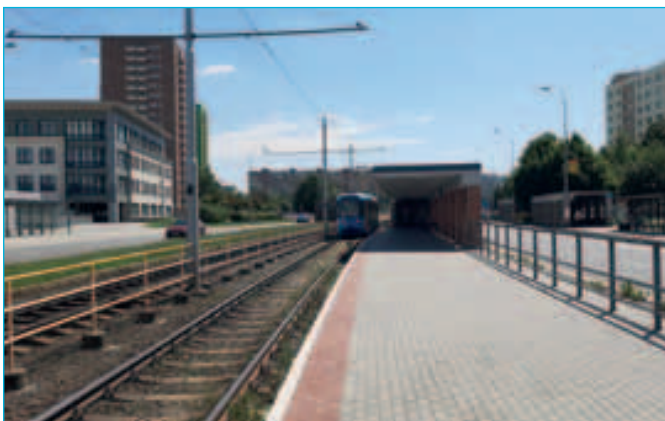
Zastávka Hotelový dům Hlubina, rekonstrukce nástupiště
