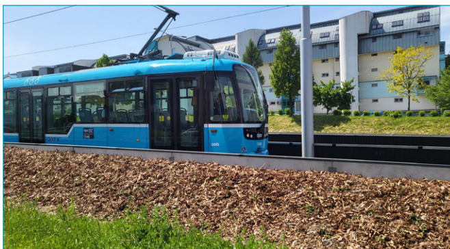
Pevná jízdní dráha vč. nízkých protihlukových stěn na ul. Horní
