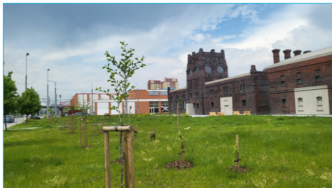
Městská jatka po rekonstrukci
