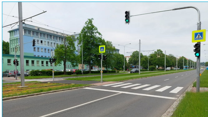
SSZ přechod pro chodce na ul. Opavská, poliklinika
