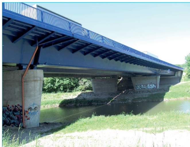
Rekonstruovaný most sil. I/11 - 140..2 ul. Rudná přes Odru
