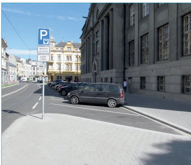
Rekonstruovaný parkovací záliv ul. Nádražní
