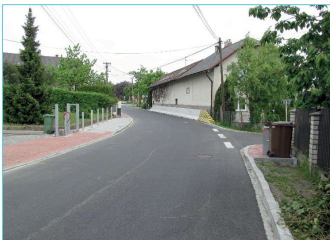
Rekonstrukce ul. Zauliční, Krásné Pole
