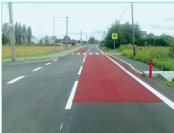
Souvislá údržba sil. II/478, ul. Krmelínská
