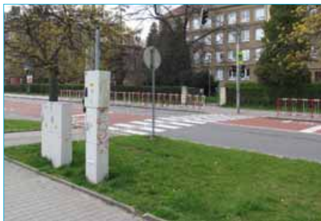
Rekonstruované SSZ přechodu pro chodce ul. Porubská
