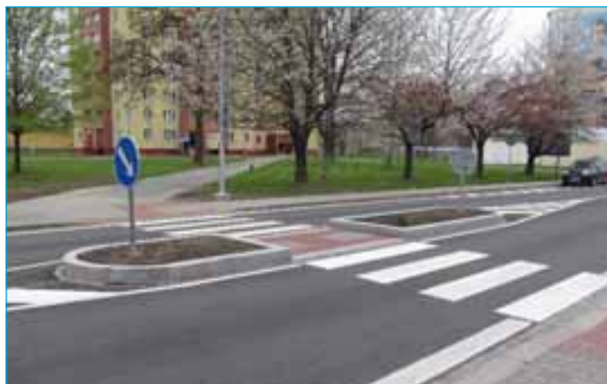
„Plnohodnotný“ ochranný ostrůvek, ul. Poděbradova
