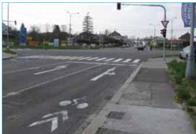
Rekonstruované SSZ kř. 17. listopadu x Vřesinská
