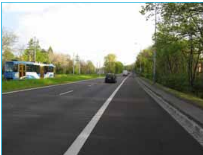
sil. II/647 ul. Plzeňská – most přes tramvajovou trať
