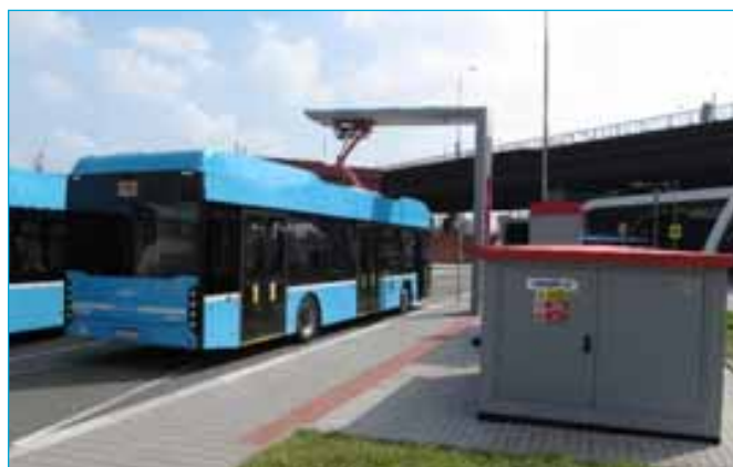
Nabíjecí stanice, Svinovské mosty
