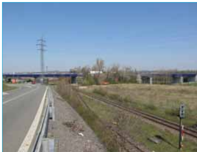
I/11 ul. Rudná – most přes železniční vlečku a řeku Ostravici
