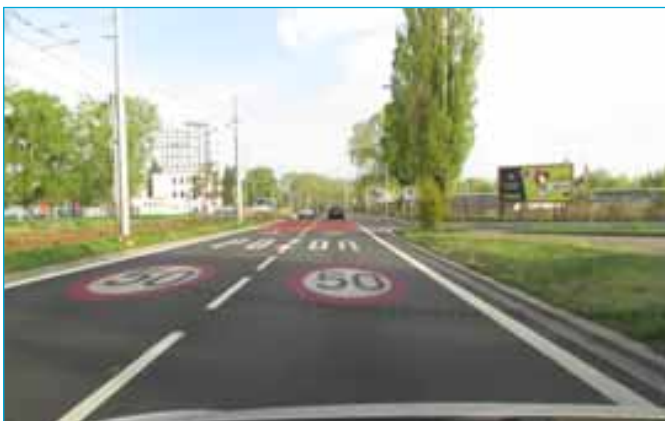
Zvýraznění přechodu pro chodce z pohledu řidiče, ul. Plzeňská
