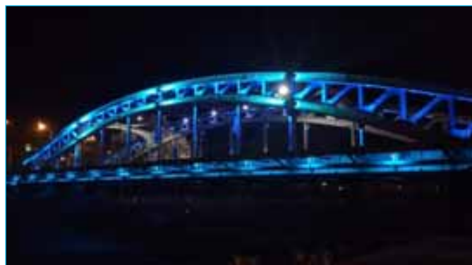
Nové nasvětlení Mostu M. Sýkory
