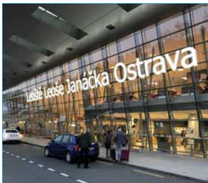
Hlavní vstup letištního terminálu
