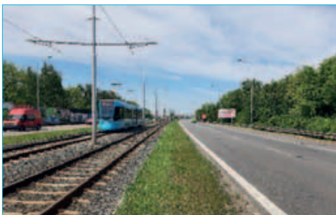
Pevná jízdní dráha na ul. Opavské
