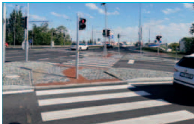
SSZ kř. Výškovická x U Výtopny v rámci stavby Výškovické mosty
