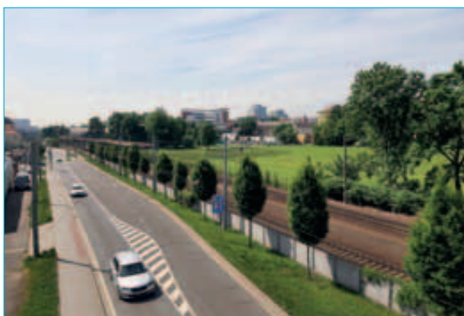
Železniční zastávka Ostrava-Stodolní
