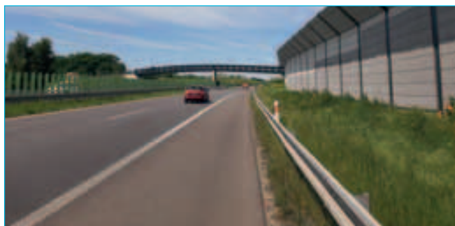
Nová lávka přes „Prodlouženou“ ul. Rudnou
