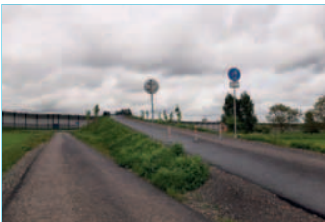
Stezka přes novou lávku nad „Prodlouženou“ ul. Rudnou
