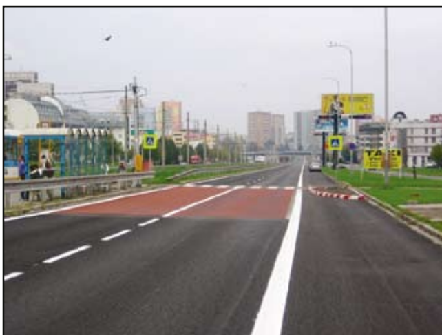
Výměna obrusné vrstvy ul. Horní
