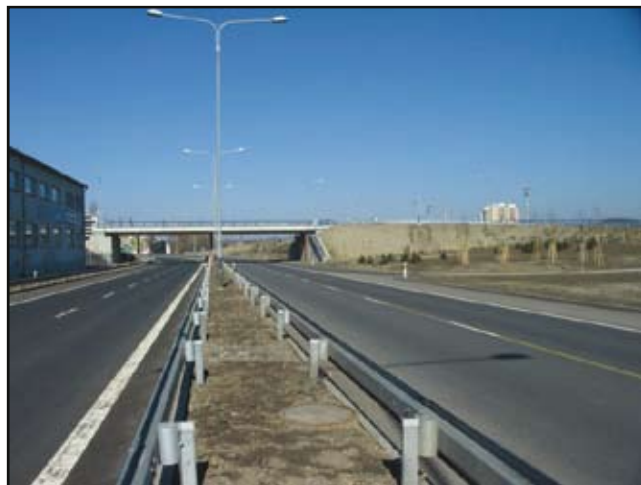
Sil. č. I/56 Místecká, II. stavba
