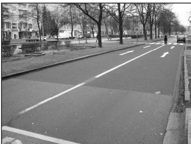
povrch s vysokou adhezí, ul. Hlavní třída
