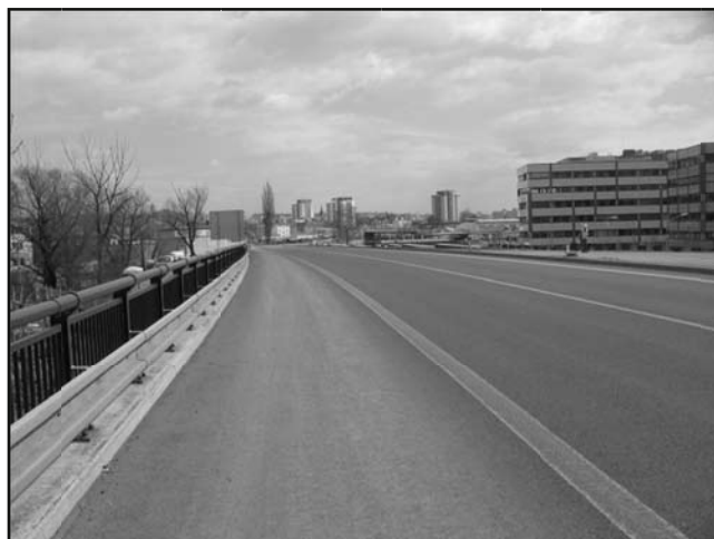
Ul. Místecká, II. stavba
