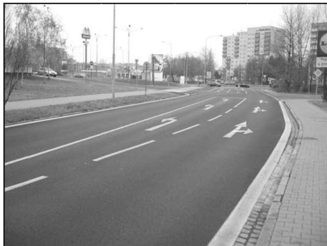
souvislá údržba ul. U Stadionu
