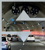
Tunelový komplex Blanka Zkušební provoz
