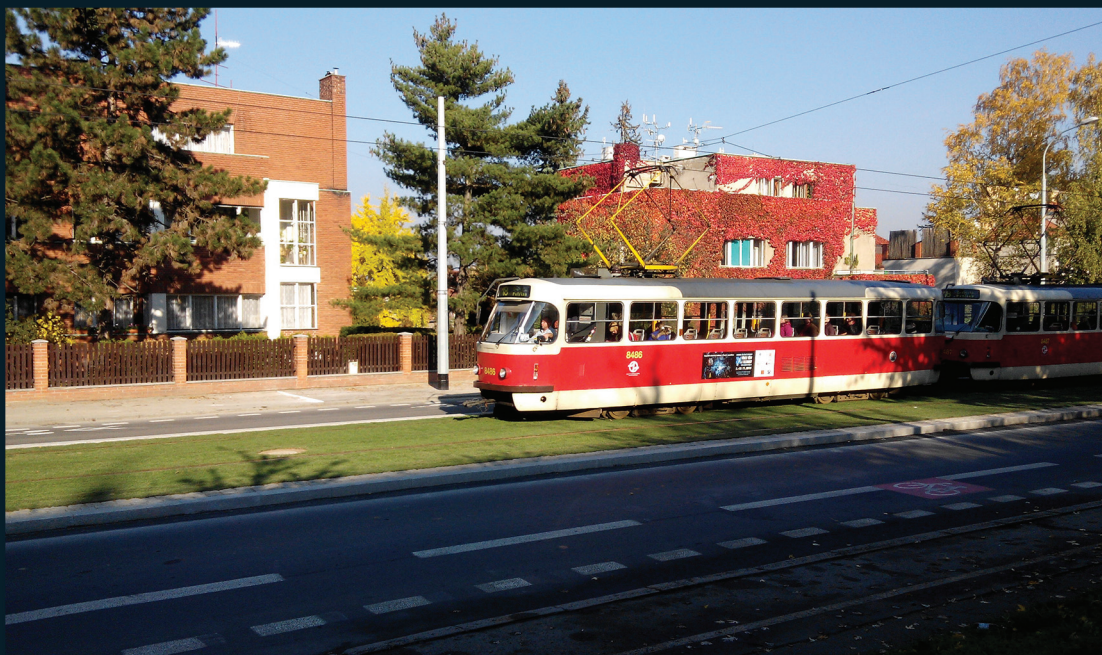
Rekonstrukce tramvajové trati Střešovická
