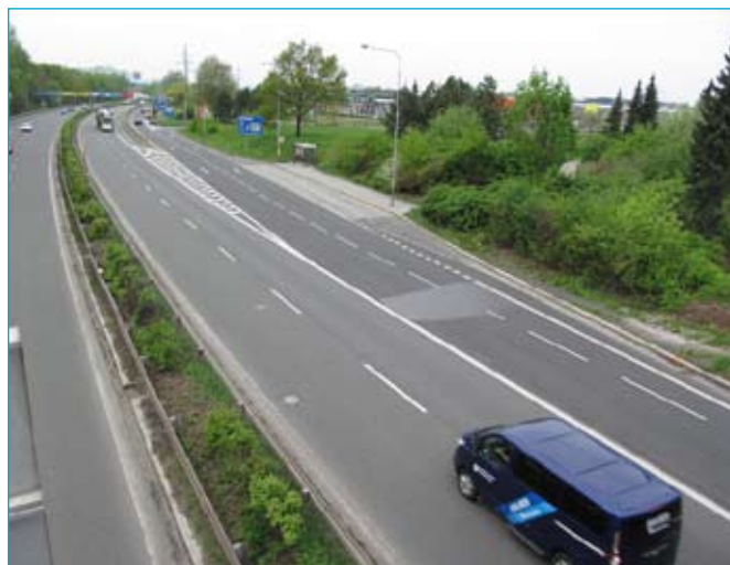
I/11 Ostrava, ul. Rudná – kolektorová vozovka
