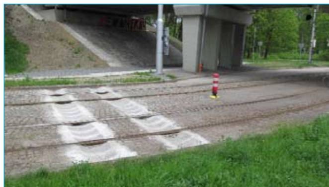
Drobná úprava proti vjetí vozidel na tram. trať, ul. Palkovského
