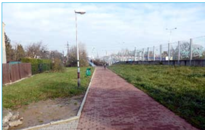
Stavba stezky na trase P, podél ul. Místecká, resp. tram. trati
