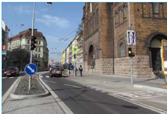
Rekonstruovaný řízený přechod pro chodce Husův sad
