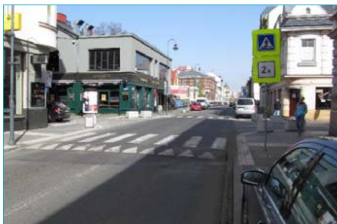
Zvýšená plocha křižovatky Poděbradova x Stodolní, Moravská Ostrava
