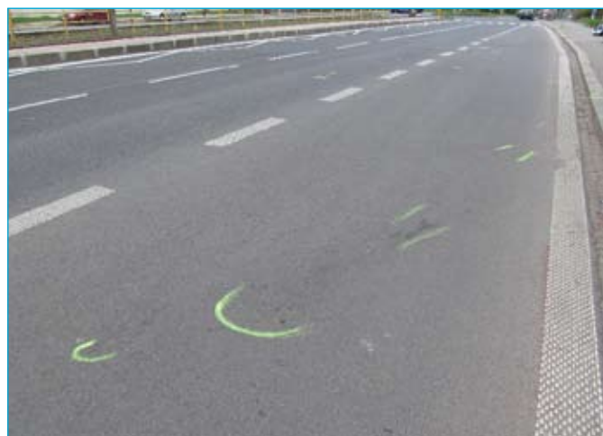
Vyznačení nehodového děje při vyjetí vozidla mimo komunikaci
