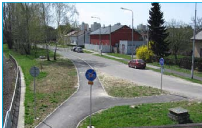
Stavba stezky pro cyklisty na trase P, ul. U Haldy, Vítkovice
