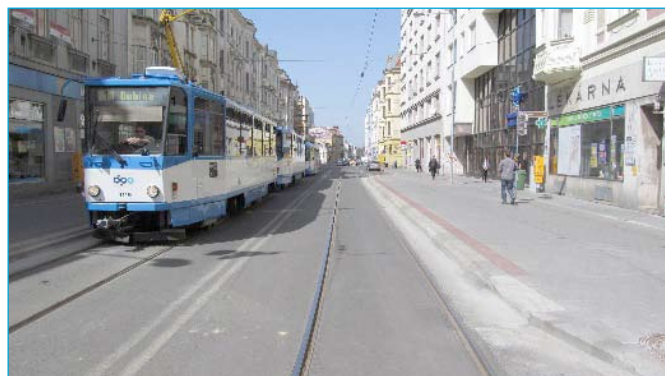
Rekonstruovaná ul. Nádražní
