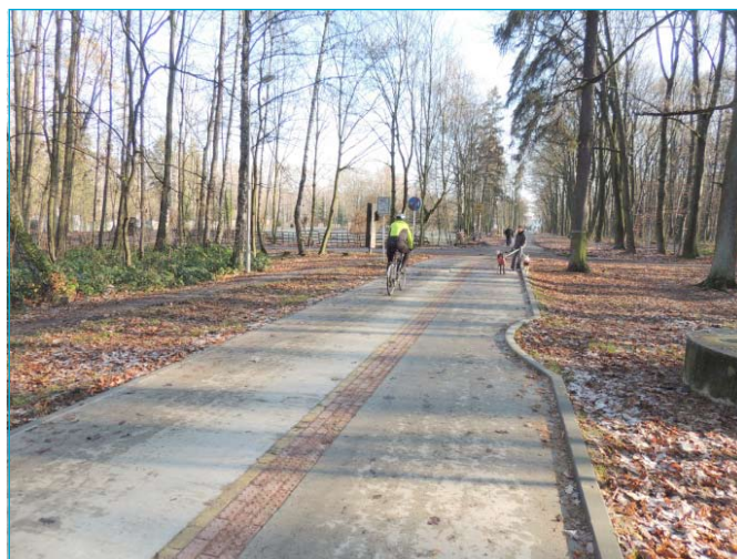
Rekonstruovaný úsek v Bělském lese
