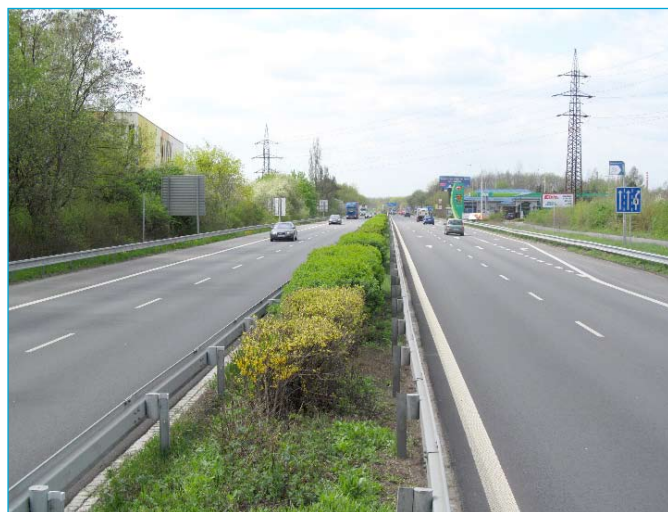
„Rekonstrukce sil. II/647, ul. Mariánskohorská
