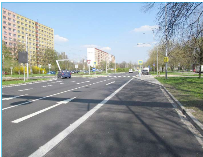
Rekonstrukce ul. Dr. Martinka směr ul. Místecká
