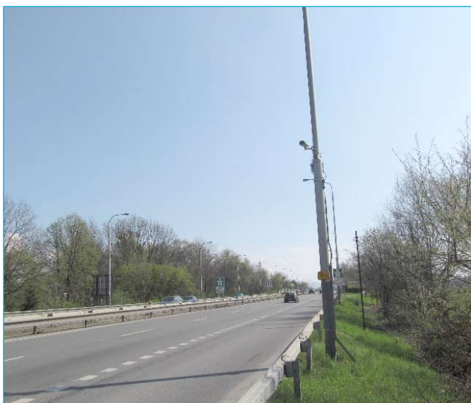
Sčítání vozidel pomocí virtuální smyčky, sil. I/56 Místecká
