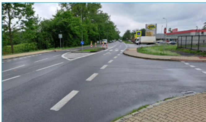
Ul. Frýdecká, přechod pro chodce vč. bezpečnostního ostrůvku
