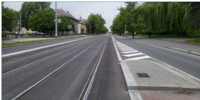
Pevná jízdní dráha na ul. 28. října
