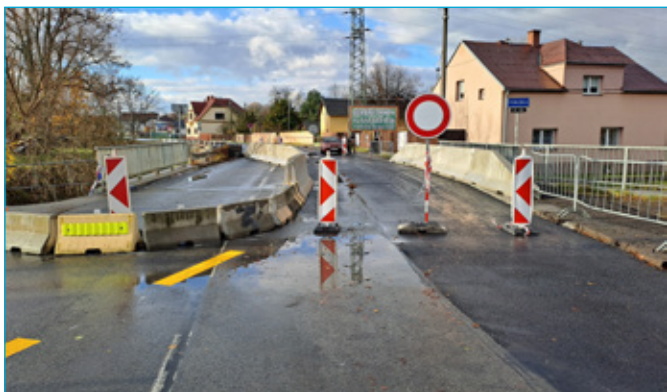
Ul. Nad Porubkou, most OV 486 přes tok Porubka – příprava provizorního zprovoznění po povodních
