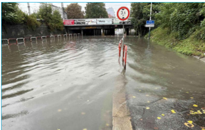
UI. Mariánskohorská, podjezd pod tratí ČD
