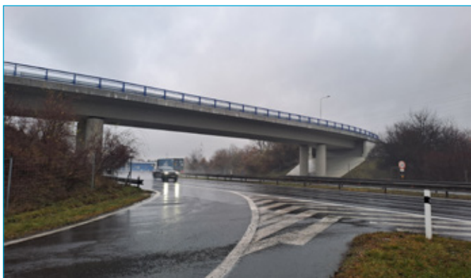
Ul. Hrabovská, most přes ul. Místecká
