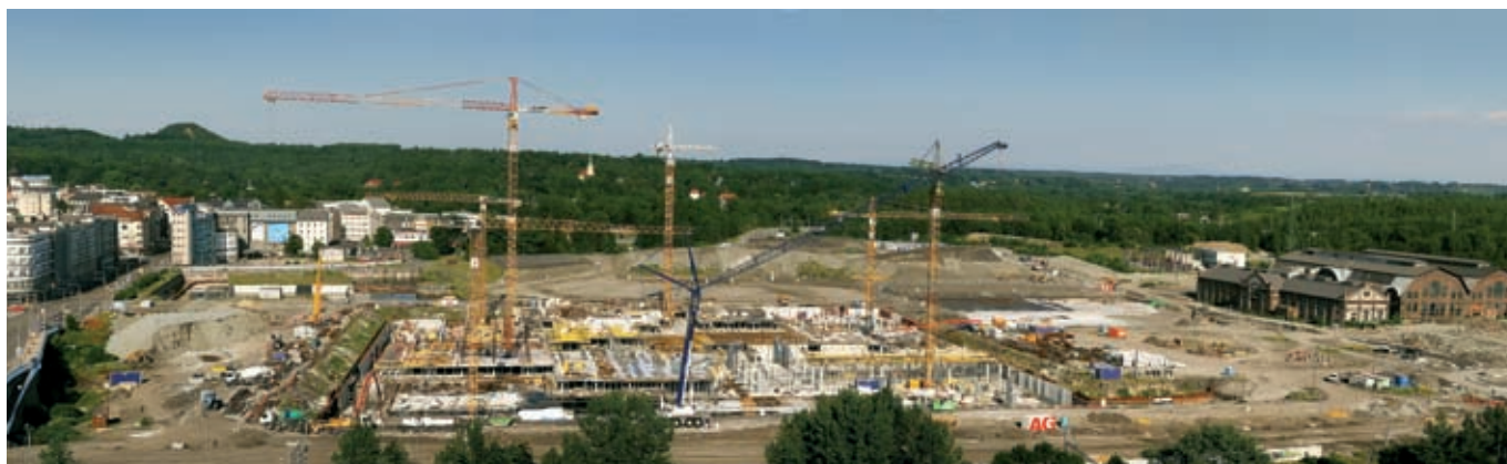
Výstavba Nové Karoliny, srpen 2010 New Karolina Building site, August 2010
