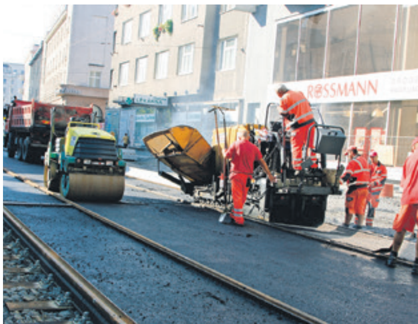
V posledním srpnovém týdnu dělníci dokončovali výstavbu tramvajové trati.
