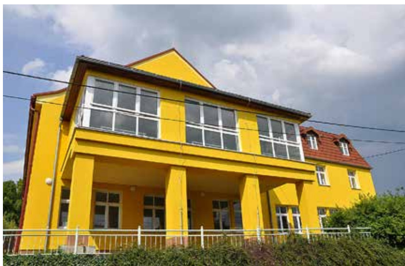
Kulturní dům v Ostravě-Hošťalkovicích se po rekonstrukci stává znovu centrem dění v obvodu. Foto: ÚMOB Hošťalkovice
