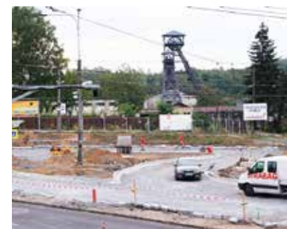
Staveniště u bývalého Dolu Petr Bezruč. Foto: B. Krzyžanek
