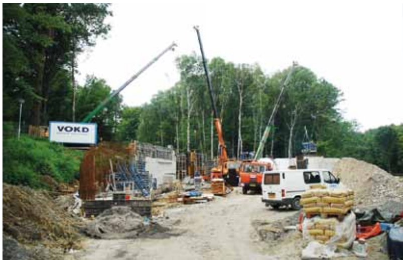
Usilovně se pracuje na výstavbě expozice pro medvědy a hulmany
