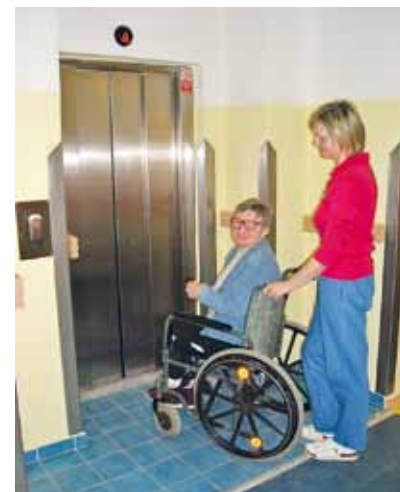
Nové, pohodlné výtahy přispívají ke zkvalitnění služeb, ale i ke snadnější manipulaci pracovníků domova například s vozíčkáři. Foto: DSS
