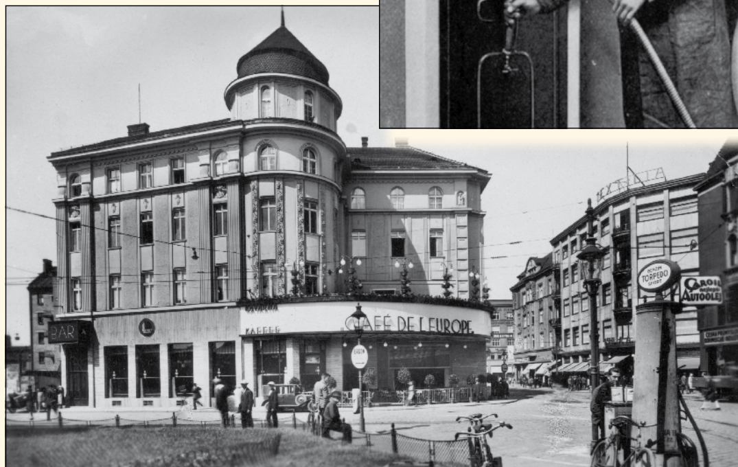
V popředí vpravo čerpací stanice firmy Naftaspol na Smetanově náměstí v Moravské Ostravě, 30. léta 20. století
