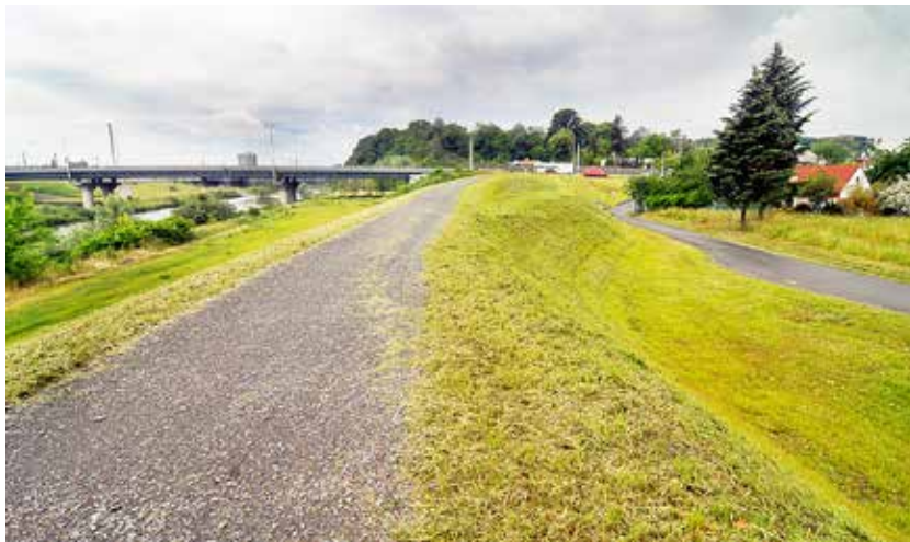
Protipovodňová hráz v Žabníku v místní části Koblov ve Slezské Ostravě
