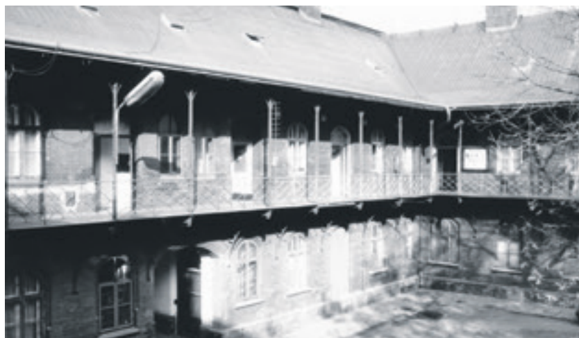
Pohled do dvora jednoho z U-domů (90. léta 20. století), které se ve Vítkovicích zachovaly dodnes.
