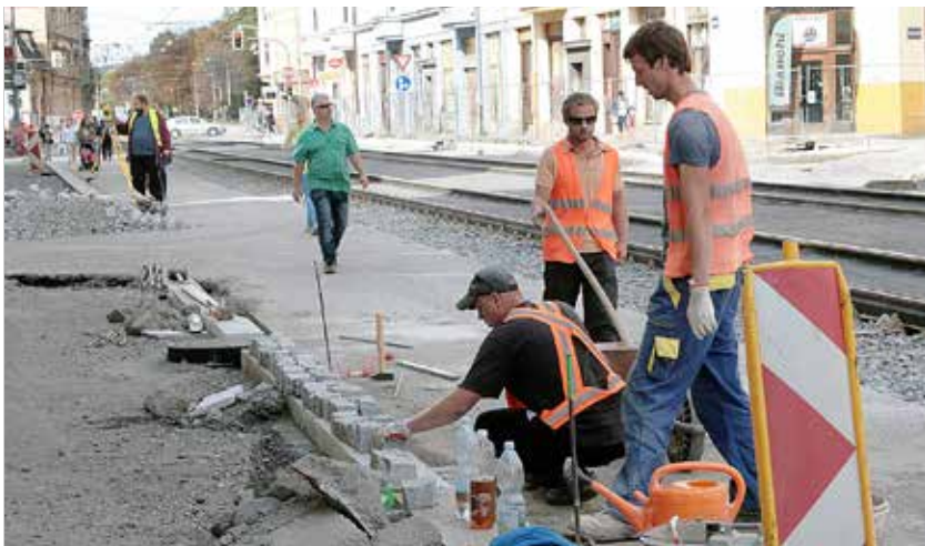
Rekonstrukce Nádražní je ve fázi obnovy vozovky a chodníků
