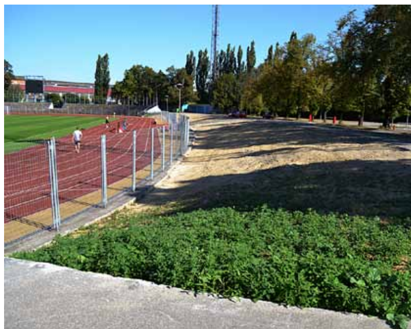
Betonové ochozy na východní straně stadionu ve Vítkovicích jsou minulostí. Na jejich místě vyroste krytá tribuna. Foto: Libor Vidlička
