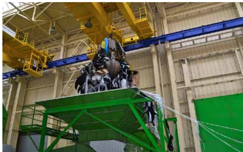
Úvodní fáze zpracování odpadu – jeřáb podává plasty do drtiče.
