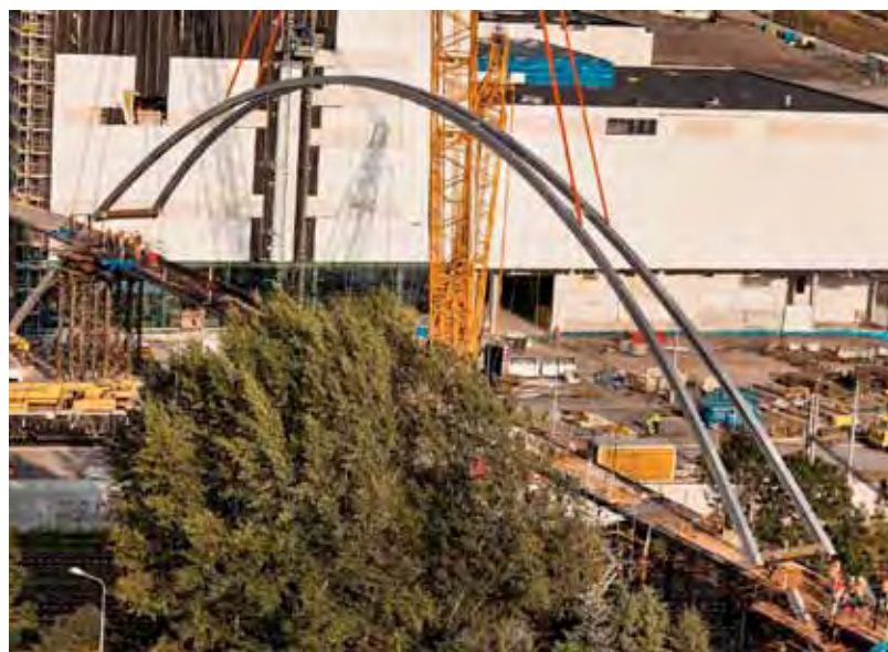
Nasazování mostního oblouku lávky, která spojuje Novou Karolinu s autobusovým nádražím, byla složitá a precizní práce.
