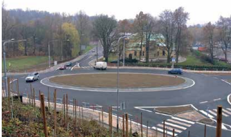
Vybudování kruhového objezdu u slezskoostravské radnice nebylo snadné. Lokalita je ve svahu, a tak si napojení na okolní komunikace vyžádalo náročnou terénní práci.
