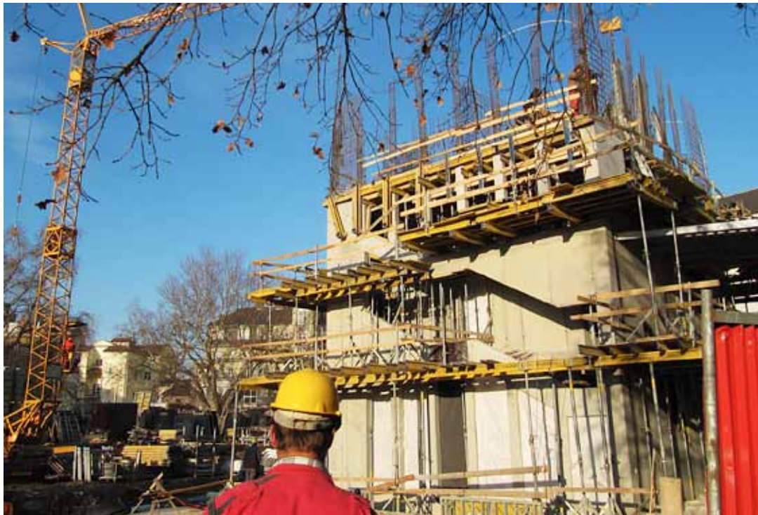
Počasí stavbařům téměř do konce listopadu přálo. V zimě se budou dokončovat vnitřní práce. Foto: Rostislav Maceček
