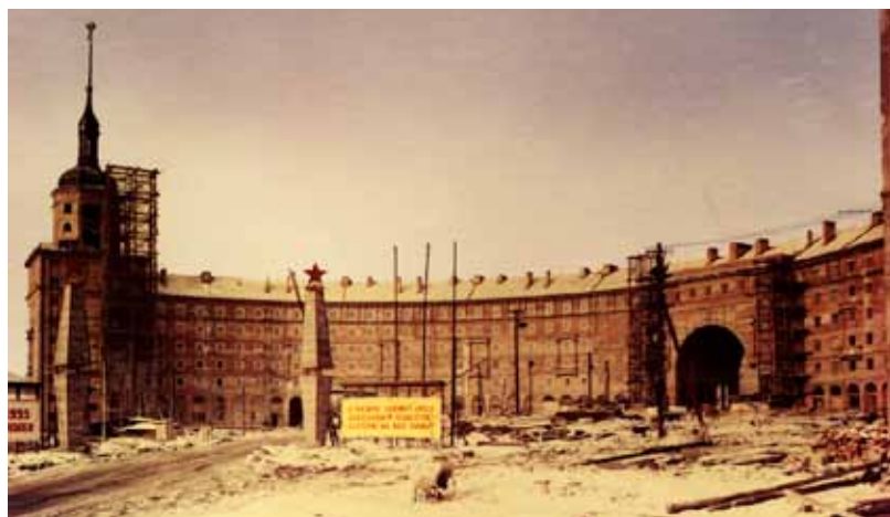
Poruba – výstavba obytného souboru „Oblouk“ (1952)
