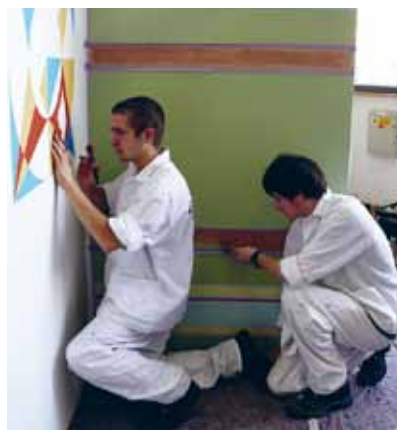
Jaromír Teichert a Adam Čopík, učni 3. ročníku oboru malíř ostravské SŠ stavební a dřevozpracující, při soutěžním zvěřování geometrického obrazce a linkování.
