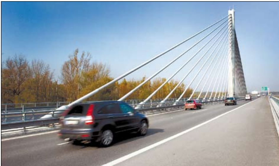
Zavěšený lanový dálniční most přes řeku Odru je pozoruhodný svým unikátním technickým řešením
