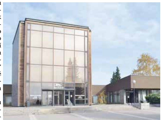
Ostravské krematorium projde rekonstrukcí. Foto: archiv MMO
