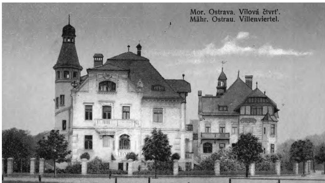
Architekt a stavitel Max Löwy projektoval a vystavěl počátkem 20. století na nábřeží Ostravice dva vilové domy pro svoji rodinu (objekt vpravo) i rodinu svého bratra Adolfa (objekt vlevo).
