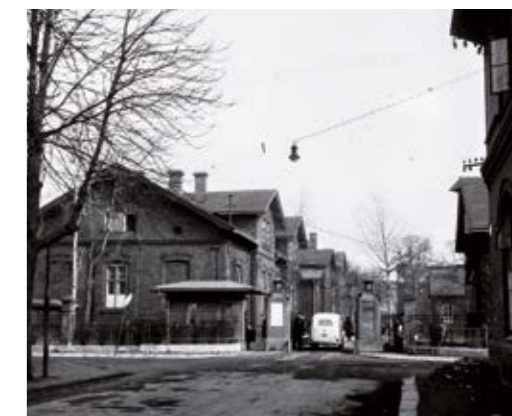
Vjezd do nemocničního areálu.
