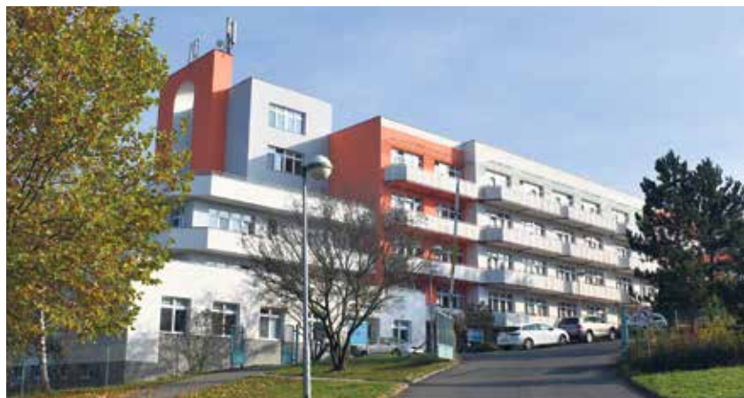
Radvanická léčebna a Dům sociálních služeb po modernizaci. Foto: René Stejskal
