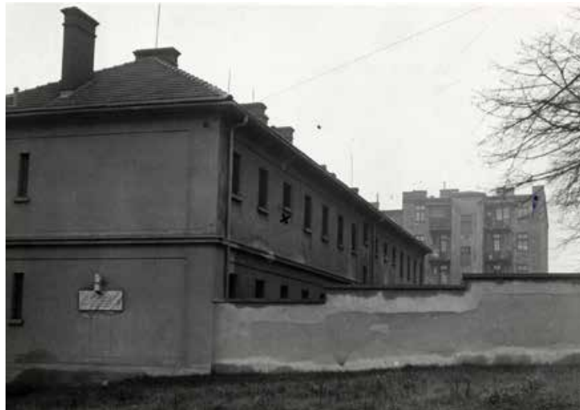
Slezskoostravská věznice před zbouráním v 70. letech 20. století.
