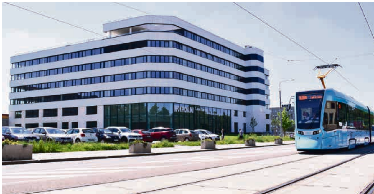
V dostavěné budově sídlí vědecko-technický park a podnikatelský inkubátor.
