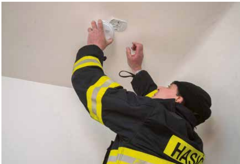
Dobrovolný hasič montuje hlásič požáru do obecního bytu v Nové Vsi. Posléze umístili detektor oxidu uhelnatého do kotelny. Foto: Jiří Zerzoň
