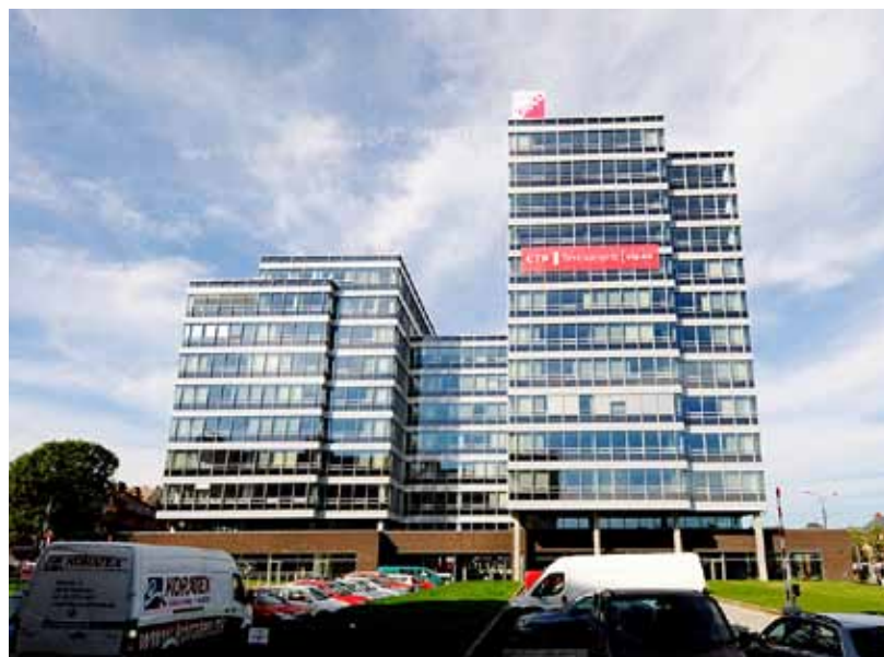
Nedaleko Fora Nová Karolina vyrostla další dominanta: budova Tieto Towers.
