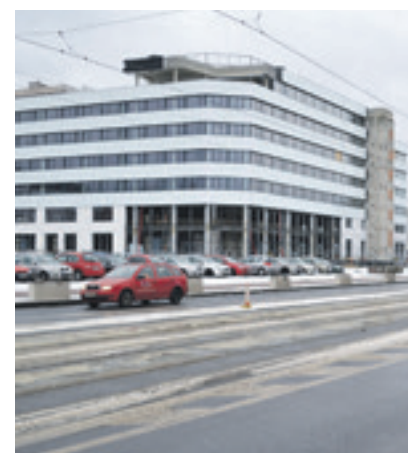
Teď už bývalý „skelet“ se pomalu mění na polyfunkční dům Smart Office Ostrava!!! Foto: R. Stejskal
