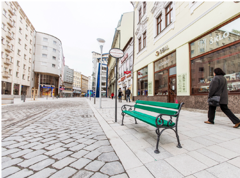
Památník s replikou zastávky a kolejemi připomíná, že právě tudy dřív jezdila tramvaj do Bohumína a Karviné.
