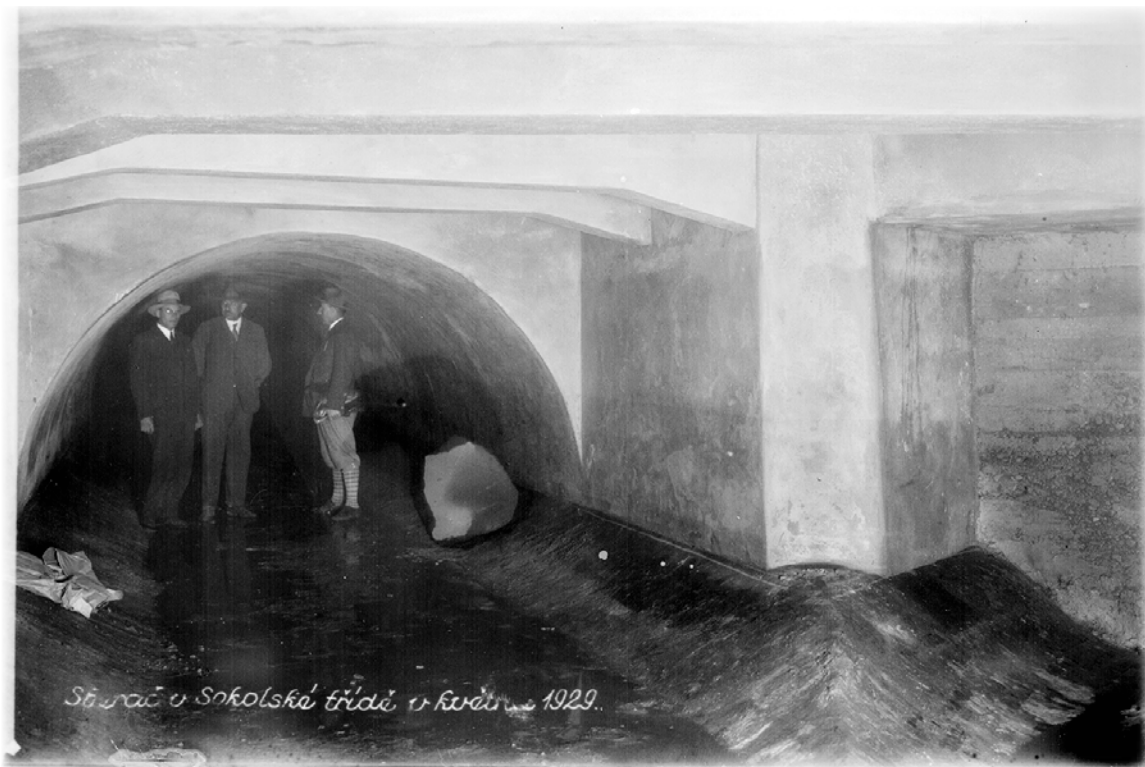
Jedním ze stěžejních úkolů nového velkoměsta bylo budování moderní kanalizační sítě. Na snímku je sběrač v Sokolské ulici dokončený v roce 1929.
