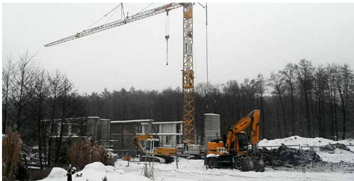
V zimě je výstavba pavilonu dočasně přerušena
