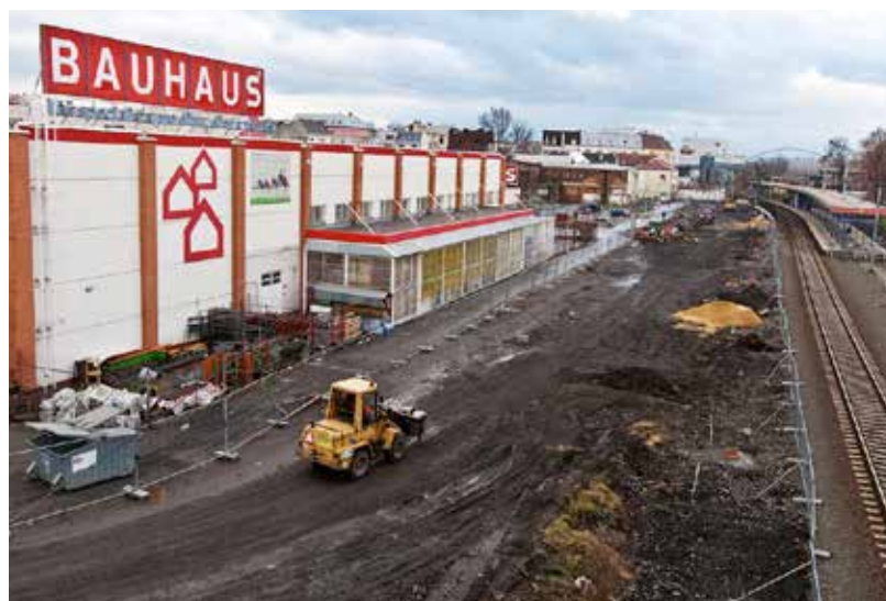
Staveniště nové Porážkové ulice mezi železniční tratí, Bauhausem, jatkami a Stodolní ulicí
