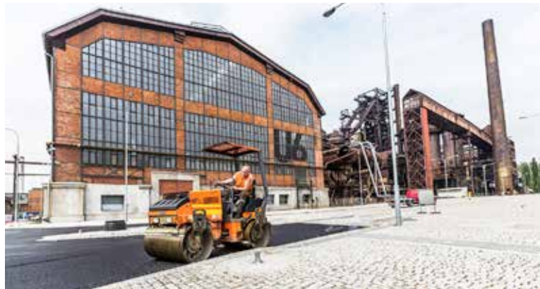
Stavbaři finišují s pracemi na Prodloužené Ruské ulici
