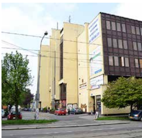
Budova v Gorkého ulici
