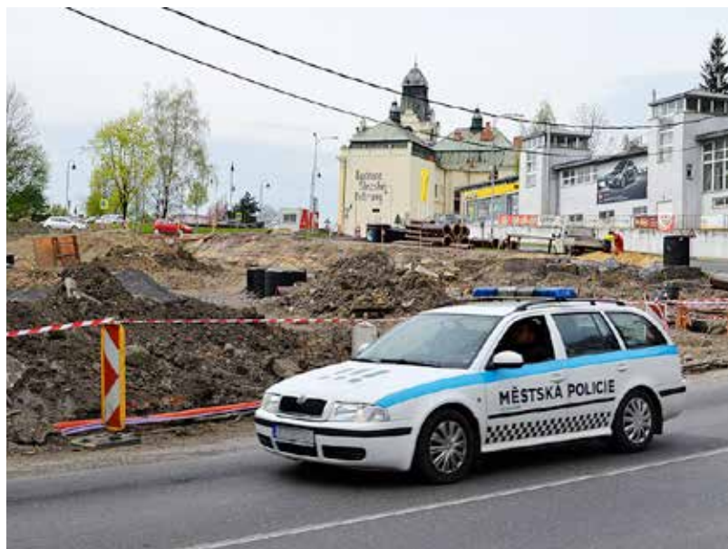
Staveniště okružní křižovatky pod slezskoostravskou radnicí má souvislost s budoucí trolejbusovou linkou z centra Ostravy na Hranečnick. Foto: Libor Vidlička
