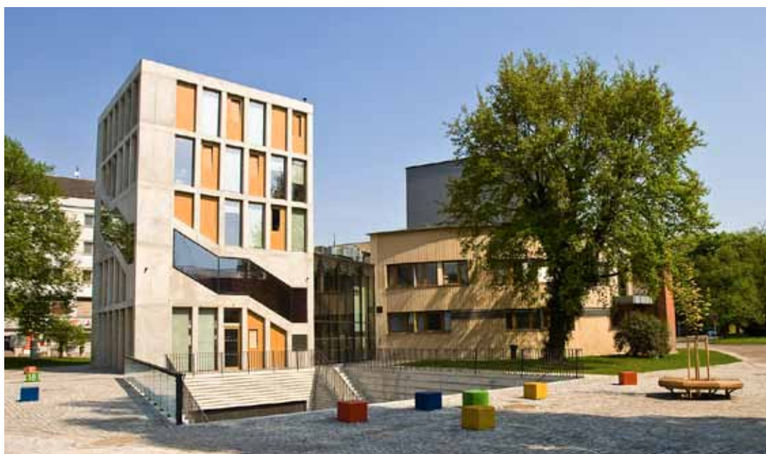
Přístavba Divadla loutek Ostrava zaujala už před několika týdny pozoruhodným orlojem, za divadlem vznikl venkovní amfiteátr.
