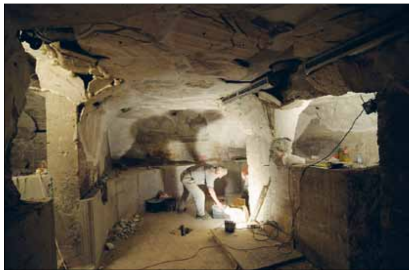
Stavba jeskyně s vodním korytem v budoucím Vodním světě SAREZA
